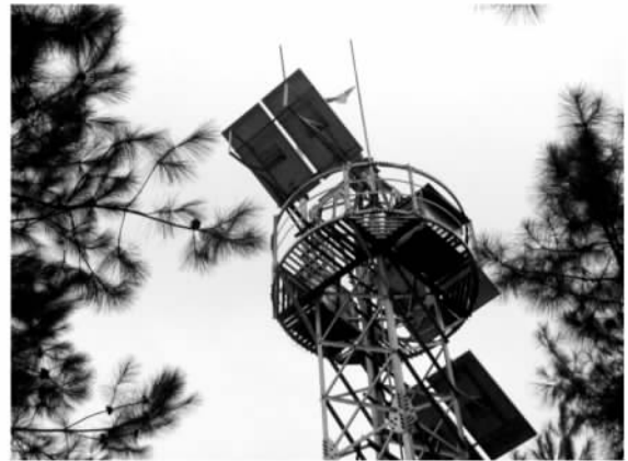
图 6 安装设备后的信息塔
