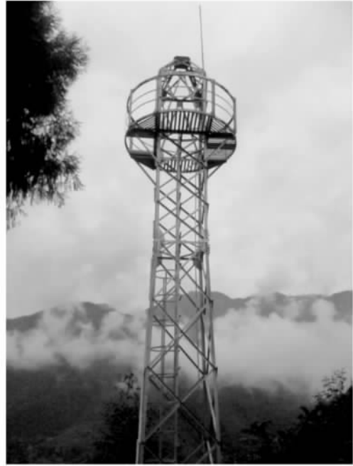
图 5 安装设备前的信息塔
