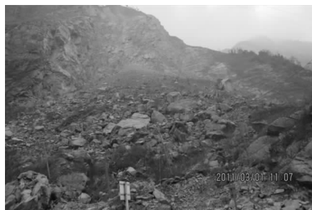
汶川县映秀镇老虎嘴崩塌山体
